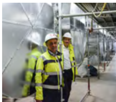
Dr. Jörg Teupen (rechts) und Projektleiter Andreas Thier inspizieren den Baufortschritt in einer der Motorenhallen.
