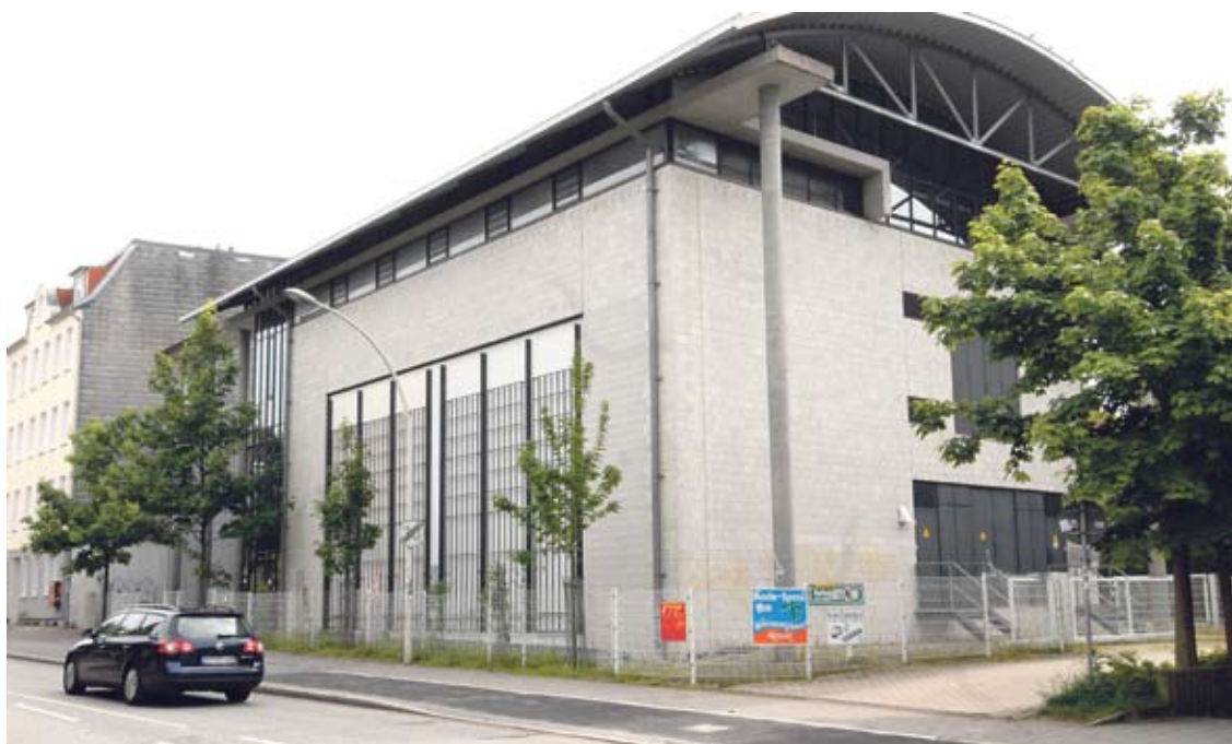
Immer unter Spannung: Hinter diesen Mauern verbirgt sich eines der Umspannwerke, in denen der Strom von 110.000 auf 10.000 Volt transformiert wird.
