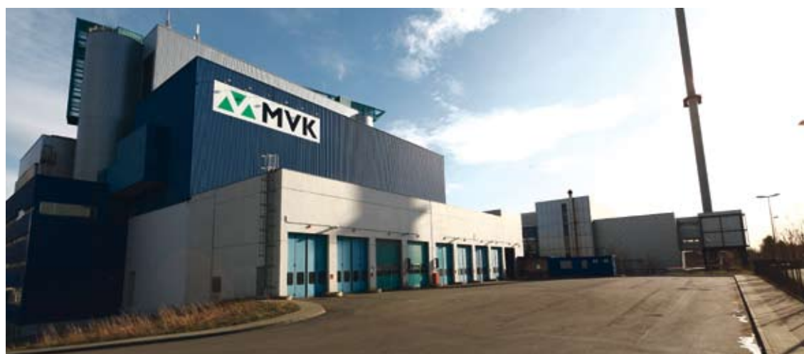
Müllheizkraftwerk seit Mitte der Neunzigerjahre: Für den Verbrennungsbetrieb nutzt die MVK von den Stadtwerken bezogenes Erdgas.
