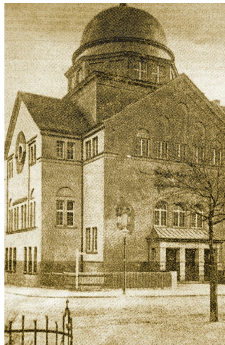
Die Synagoge in der Goethestraße: Das jüdische Gotteshaus wurde im Januar 1910 eingeweiht.
