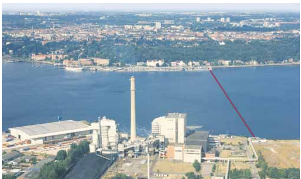
Der 1.368 Meter lange Fördetunnel verbindet das Ost- und Westufer mit Fernwärme.
