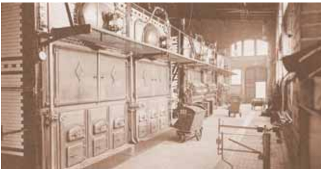
Im Kesselhaus wird die „Wärme für die Ferne“ erzeugt.
