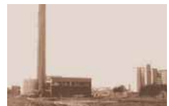
Das Inselheizwerk Mettenhof wird 1966 fertiggestellt.
