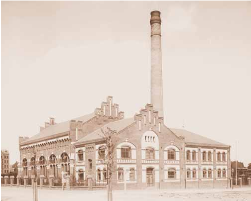
Im Jahr 1905 hält die Fernwärme in Kiel Einzug: Das Heizkraftwerk in der Humboldtstraße beheizt das Stadtwerke-Verwaltungsgebäude und ein Lagergebäude mit Wärme.
